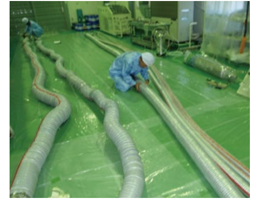
アンピリカルフレキシブルホースの整備
