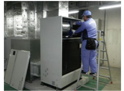
空調点検作業 (筑波宇宙センター)
