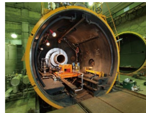
ロケットエンジン高空性能試験設備 (角田宇宙センター) (c) JAXA
