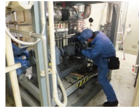
宇宙ステーション試験棟空調点検作業 (筑波宇宙センター)
