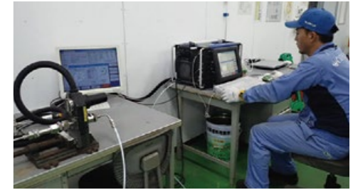
配管自動溶接作業
