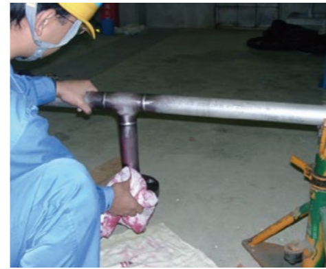
非破壊検査 (浸透探傷検査)
